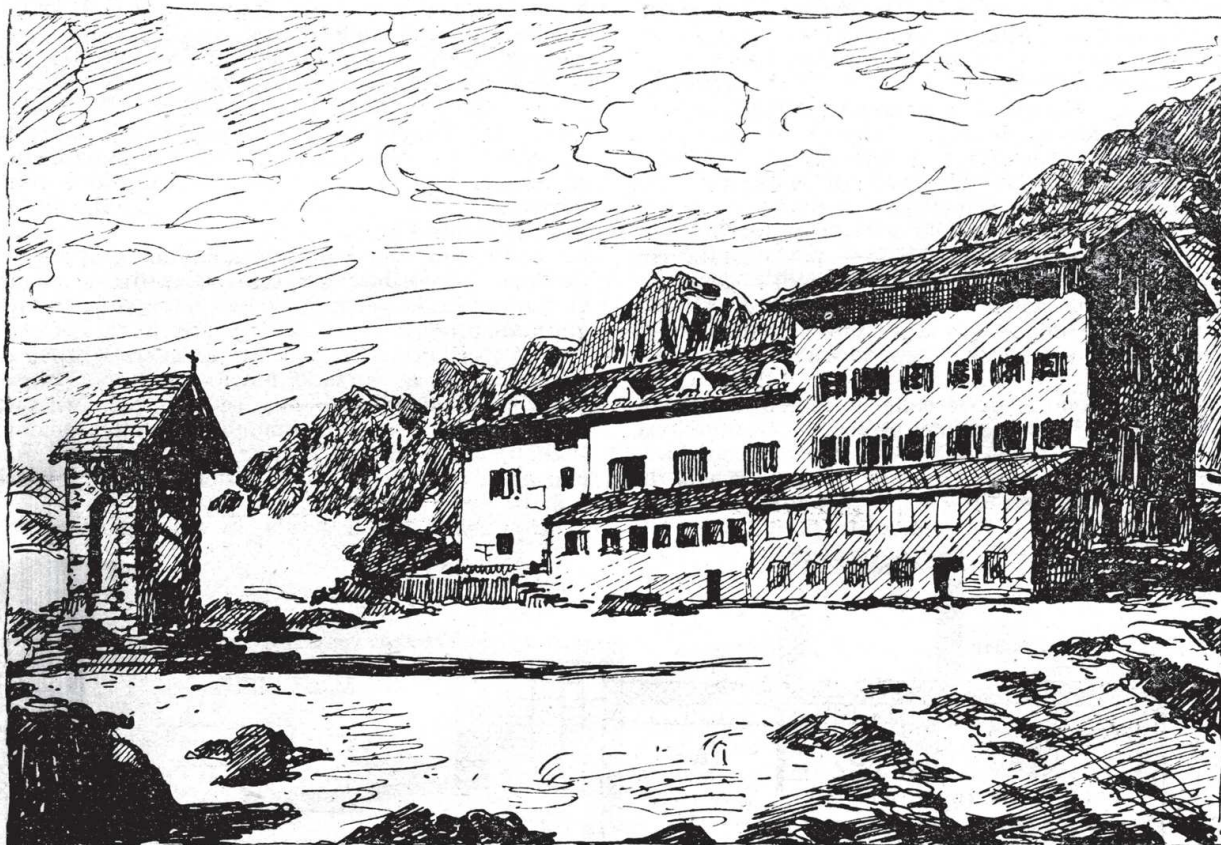
Dopo l'ultimazione dei lavori in corso
